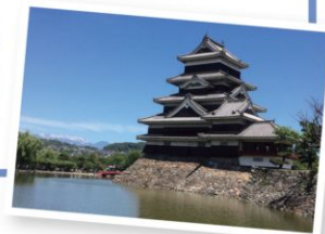
▼ 現存する五重六階の大天守として日本最古の城
